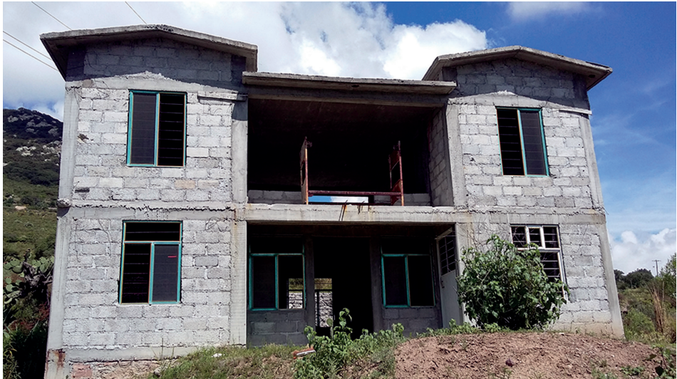
Casa en proceso constructivo, Santuario Mapethé, Hidalgo
